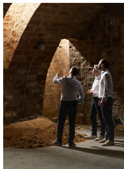
Une partie de l'ancienne cave à vin sera transformée en une voûte événementielle exceptionnelle.
